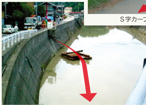
河川を横断する施工
