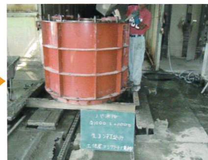
コンクリート打設
