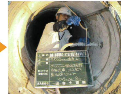
中込め充填作業
