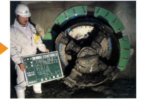
既設人孔へ直接到達 推進掘削作業の終了
