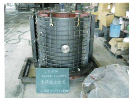
型枠組立の製作
