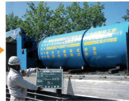
工事現場へ搬入
