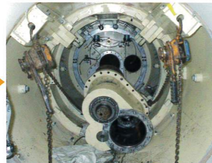
掘進機内部の解体
