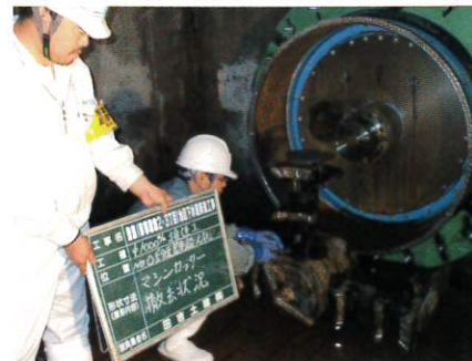
掘進機前面の解体
