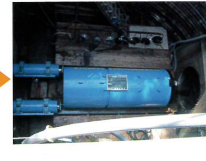
掘進機の発進
