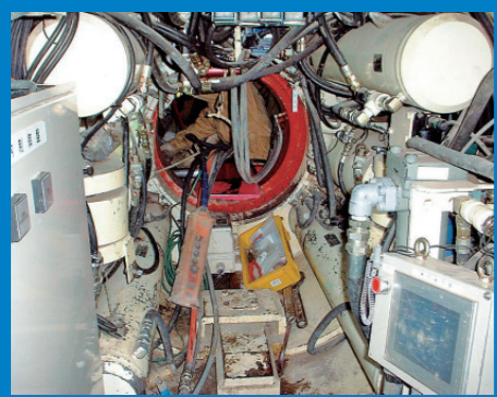
■掘進機内の様子
