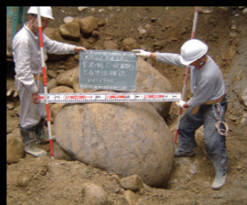
立坑掘削時巨礫確認
