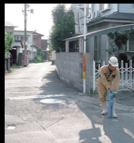
曲線施工測量状況 (電磁波測量システム使用時)
