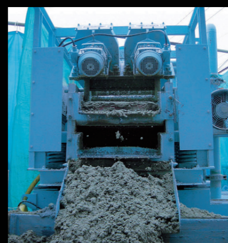
還流式泥土分離システム使用状況
