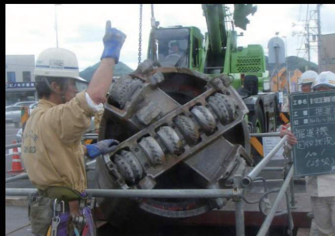
掘進機到達回収状況
