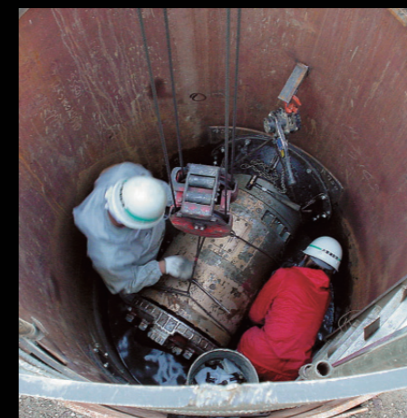
φ1500 ケーシングからの回収状況
