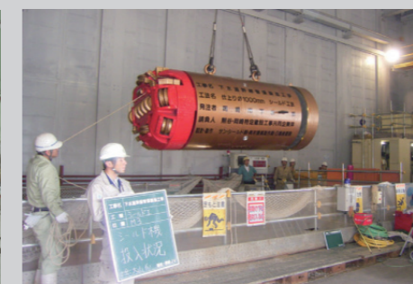
■シールド機吊降ろし状況
