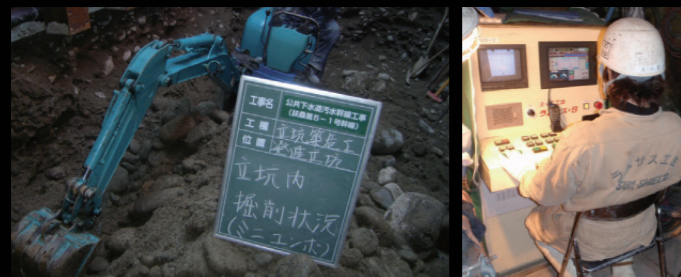
立坑掘削時の土質状況
