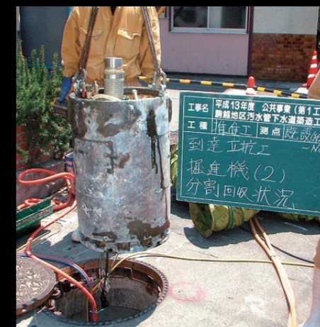
φ1200 既設人孔からの回収状況
