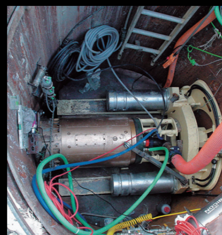
φ2000 での初期掘進状況
