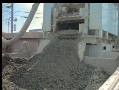
掘削残土分離状況
