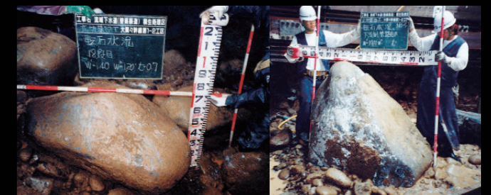
立坑にて長径 1400mm の巨礫
