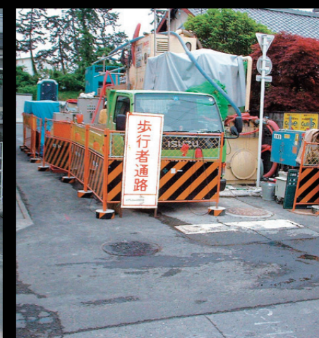
還流式泥土分離システム使用時の作業ヤード
