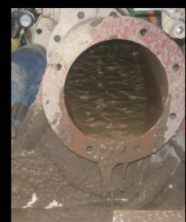
掘削排土状況
