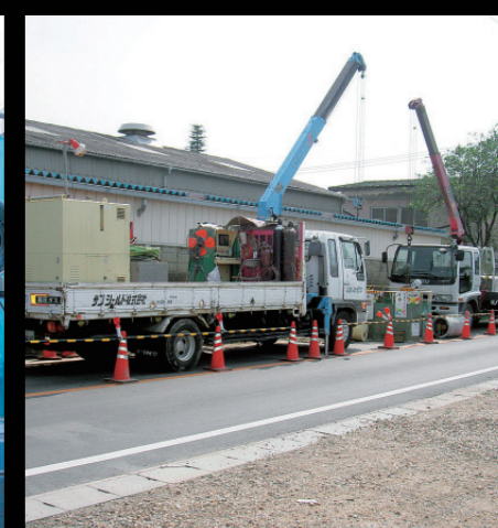
車上プラント作業ヤード
