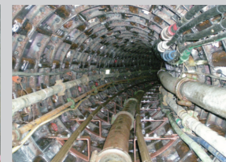
■鋼製セグメント施工
