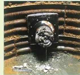
軟岩推進到達直後 土質: 泥岩(青灰色) 一軸圧縮強度: 20~30N/mm 2 管径: φ200mm
