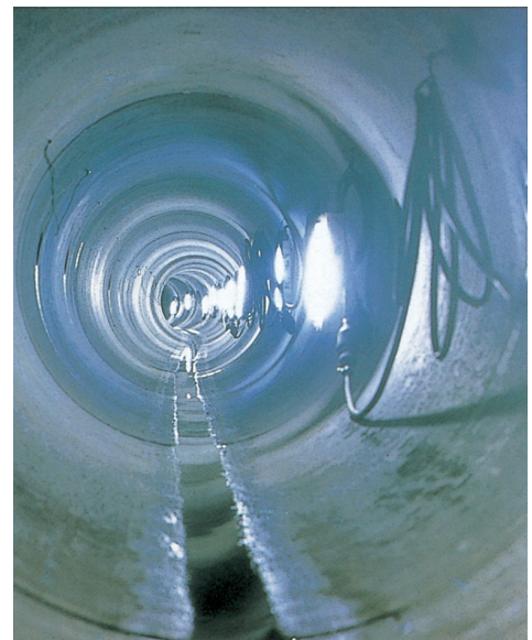
φ800 曲線100R管内状況
