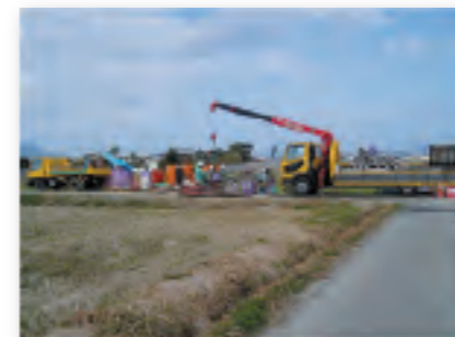
発進立坑全景
