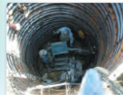
ジョイント管回収状況
