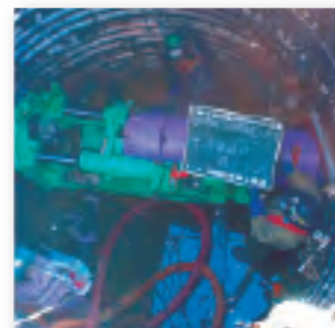
先導体据付・掘進状況
